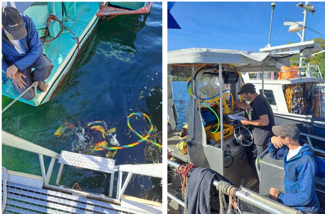
Inspection de la coque de la faucardeuse par un scaphandrier
