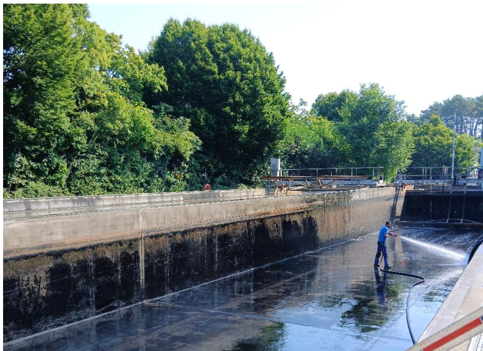
Intervention de nettoyage d'un décanteur primaire au jet haute pression
